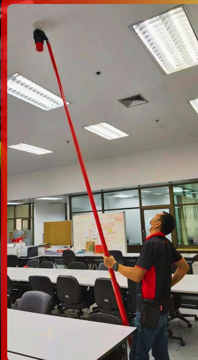
อุปกรณ์ตัวจับควัน อุปกรณ์ตัวจับความร้อน
